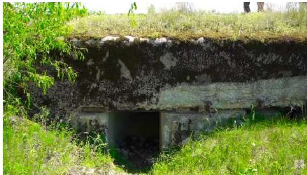
Рис. 16: Вхід до німецького доту станом на 2021 рік[9]
